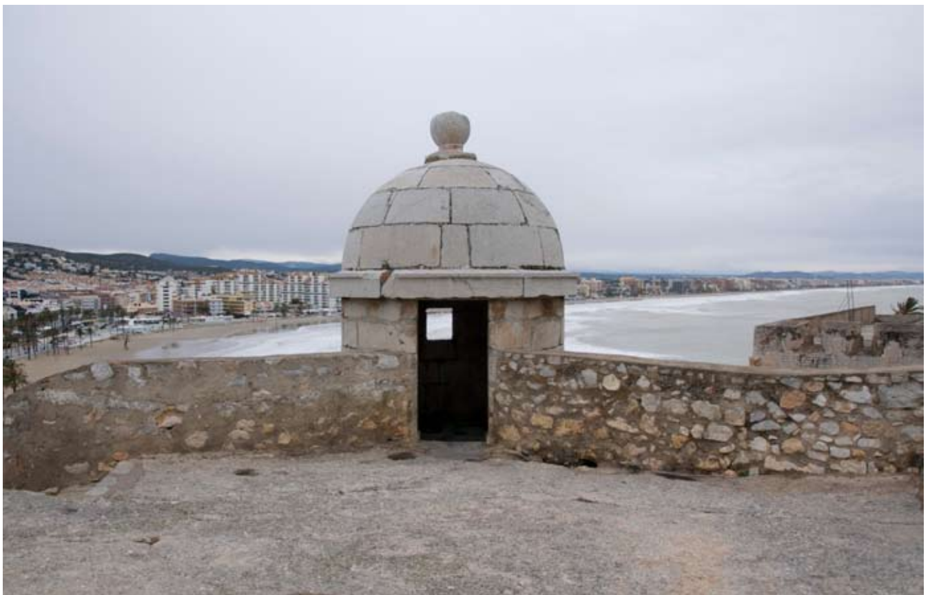
Plataforma de la garita de Felipe II. Vistas comparativas antes y después de la obra
