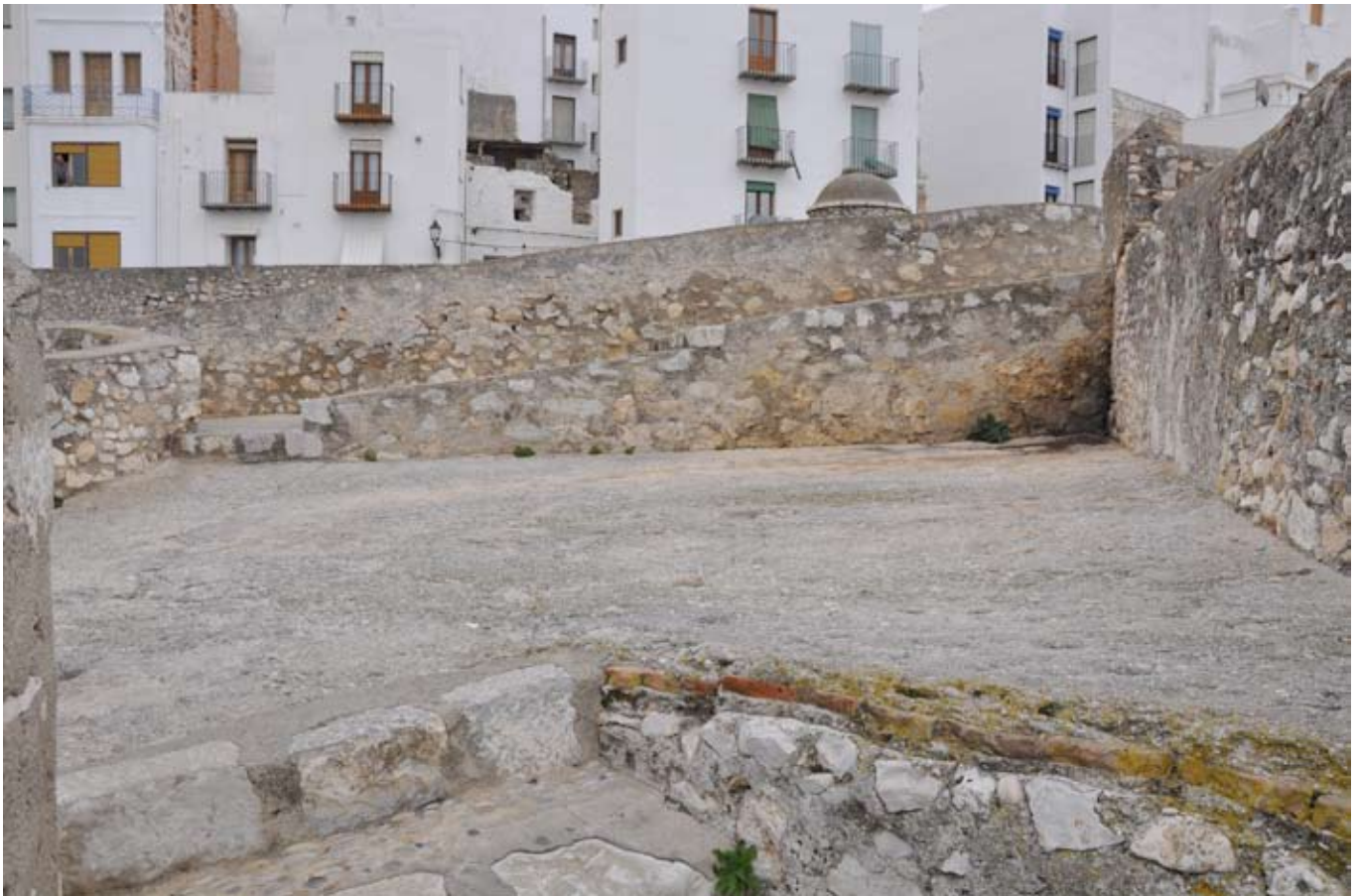
Plataforma de la garita de Felipe II. Vistas comparativas antes y después de la obra
