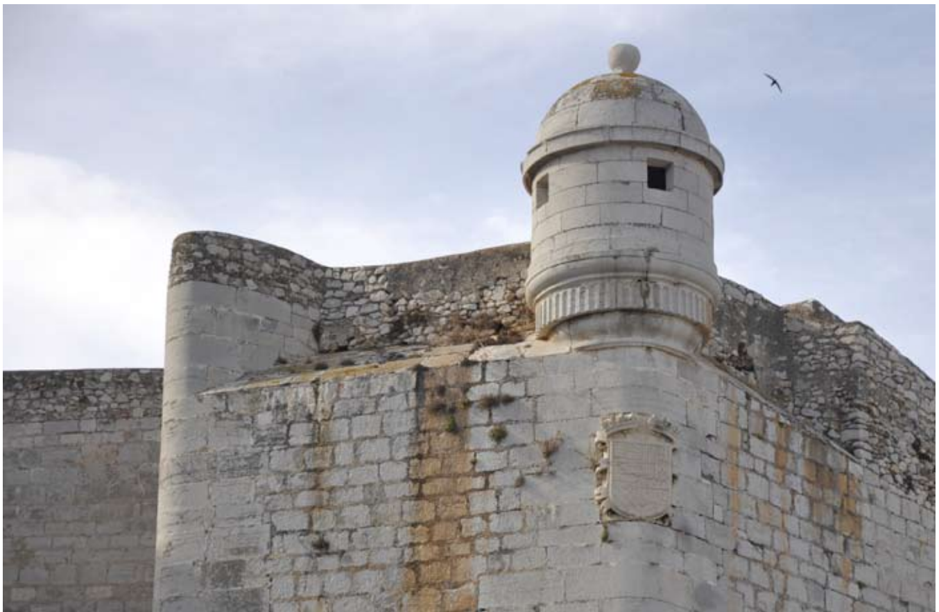
Garita de Felipe II y Balcón de Pilatos. Vistas comparativas antes y después de la obra
