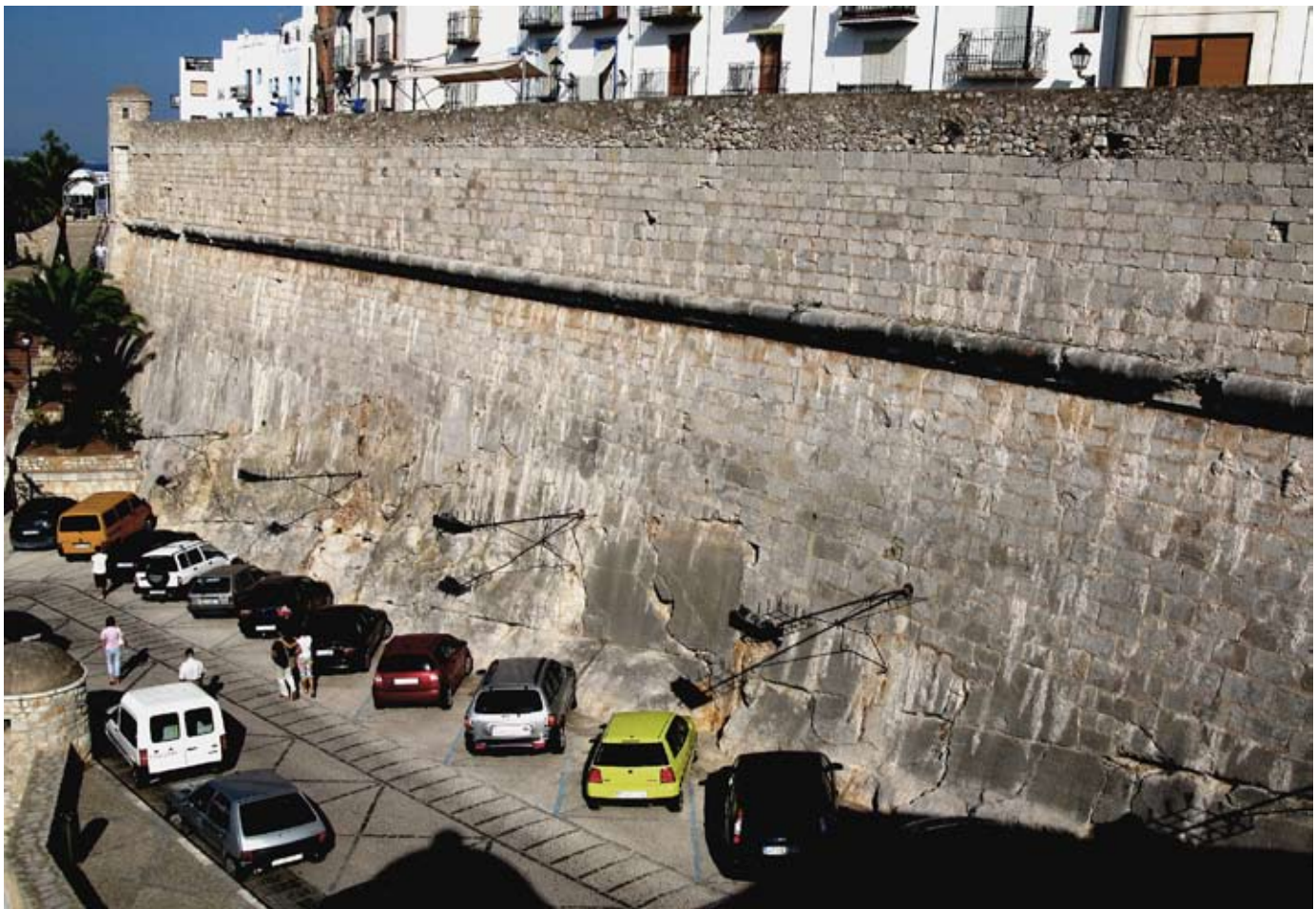
Lienzo de la Batería del Olvido. Vistas comparativas antes y después de la obra
