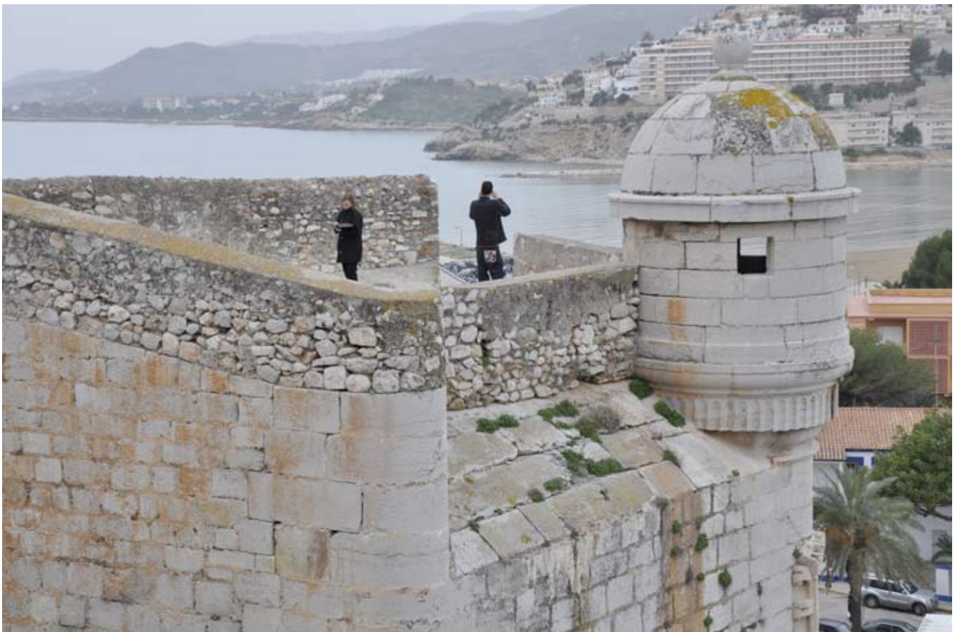
Garita de Felipe II. Vistas comparativas antes y después de la obra
